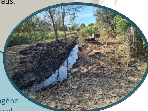
Travaux El Comunal - RIVAGE 2023
