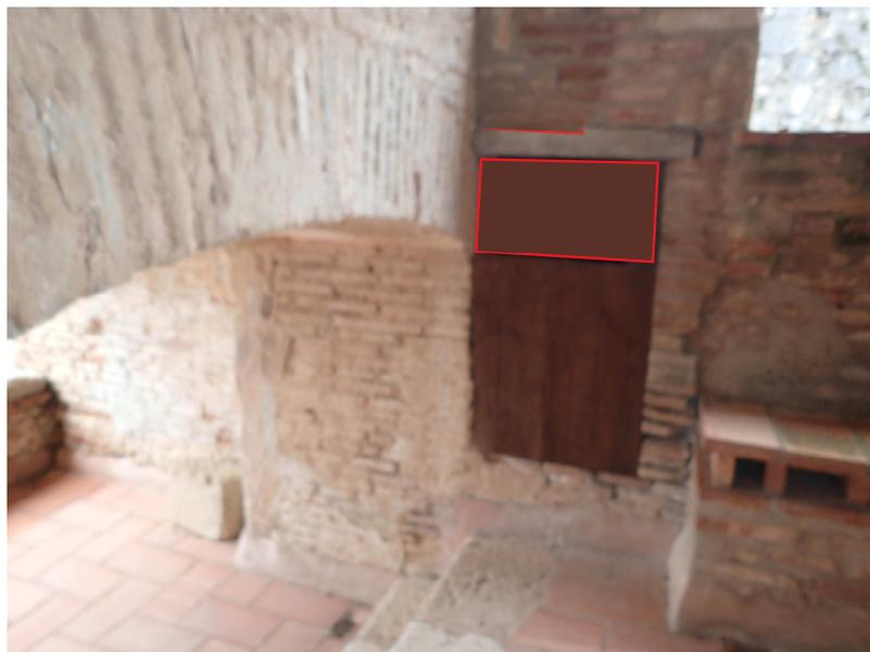
**Photo.-** Portillon à créer (encadré rouge) au-dessus de la porte existante (salle sous l'horloge au niveau 5, mur nord).
